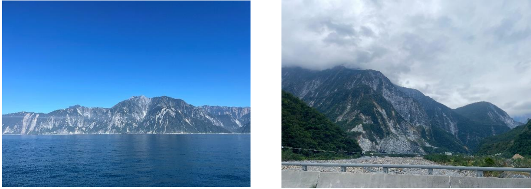
圖 28、圖 29、0403 花蓮大地震後清水斷崖及山坡地土石崩落之慘況
