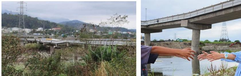
※富里明里大橋的中間橋墩陷落傾斜已封橋
