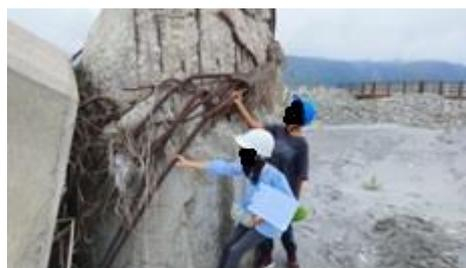
高寮大橋的墩柱箍筋圍束力不足(箍筋都斷開)
