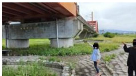
玉里客城鐵路陸橋的倒三角圓柱和鋼橋段的雙圓柱
