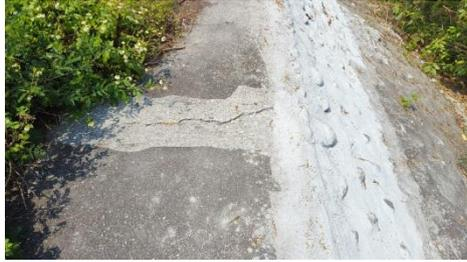
瑞穗大橋引道路面開裂修補、側坡和堤防補強
