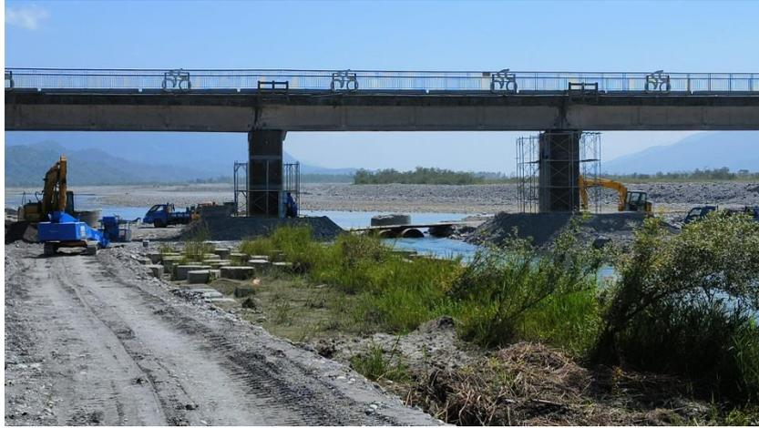
舊玉里大橋樑墩柱防震容量補強(焊接包覆鋼板)
