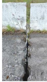
玉長大橋震後損毀的墩柱和伸縮縫
