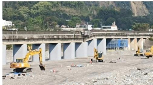
舊玉里鐵橋墩柱鋼板包覆焊接
