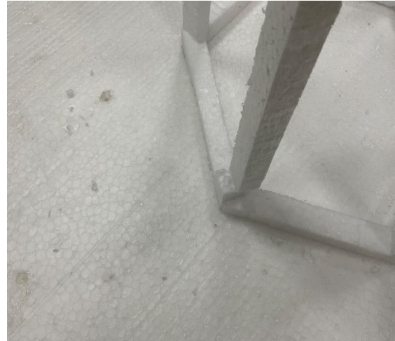
圖 3、六角結構破損
