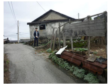
照片 1-3 面向東南，大地震前原為平地，破裂後形成約 1.6 米落差，為方便村人行走填土成斜坡
