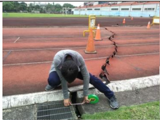
花田徑場出現兩長條裂縫，最大寬度 12 公分，可觀察到左移錯動
