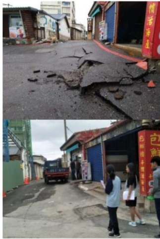
七星潭店家前路面壟起破裂，抬升方向與上左圖海灘抬升平行，上圖為網路照片 劉彥求攝。
